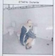
instalación de 3 inodoros con sus respectivos tanques de agua, instalación de 2 lavamanos con sus respectivas griferias.
