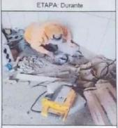
Modificación de la tubería para instalar los inodoros.
