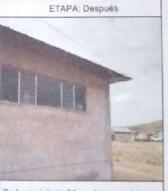
Se ha instalado 01 ventana en sistema perciana con vidrio griss de 273 X62, 02 ventanas en sistema con vidrio gris de 101X98
