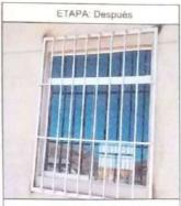
se ha instalado 02 protectores de ventana de 1.20m x 1.20 m y otra dela siguiente medida, 1.6m x 1.6 m con angular de una y fierro liso de media.
